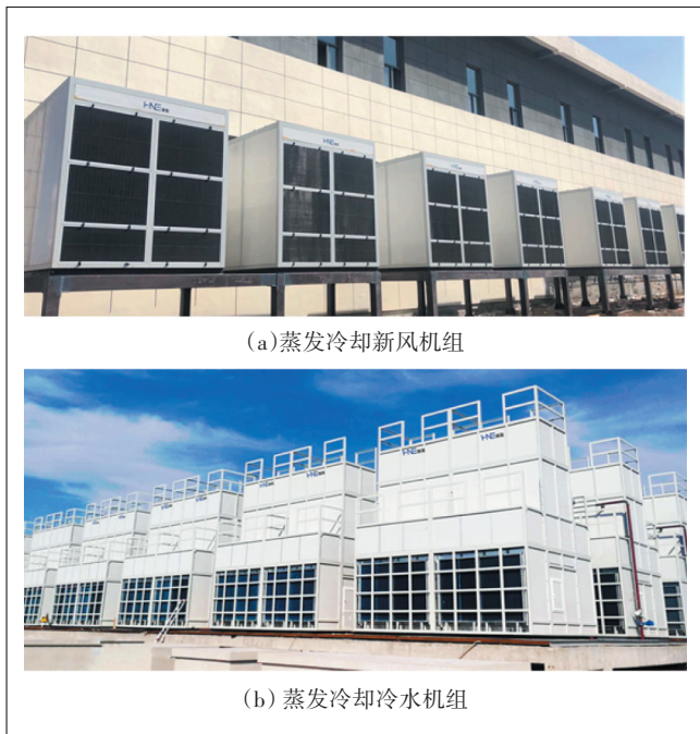
图6 项目机组实物图
