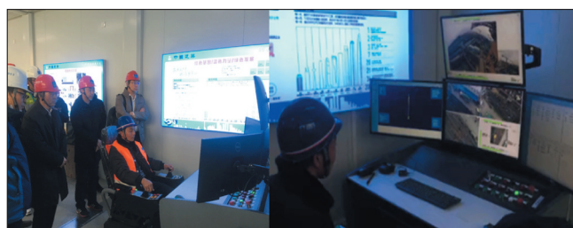
图4 塔吊远程操控
