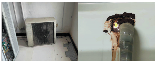
图1 某基站室内环境及穿墙洞
