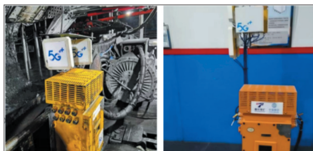
图5 煤矿井下皮基站安装示意
