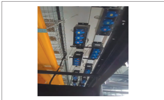
图6 机房智能小母线插接箱布置
