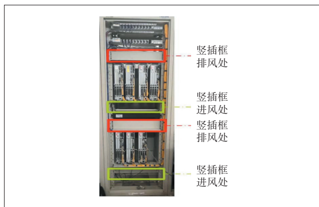
图1 竖装BBU机柜正视图
