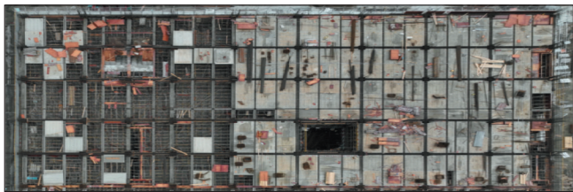
图1 装配式建筑施工现场俯视图
